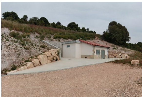
Imagen 2. Depósito Leciñana. Exterior
