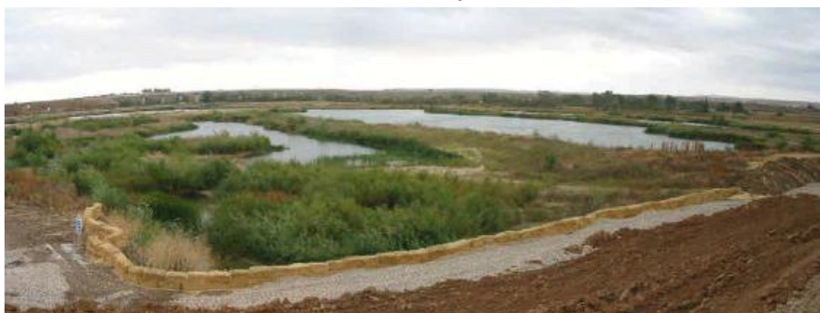
Colocación de barreras de retención de sedimentos entre una masa de agua a proteger, y el ámbito de obra.
