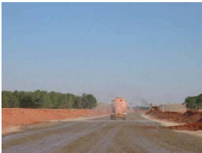
Riegos superficiales de las superficies afectadas por las obras.
