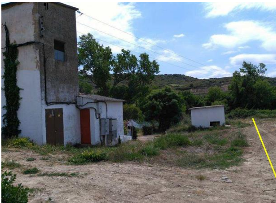
Imagen 10 Vista de las edificaciones en la zona de desagüe, la conducción iría aproximadamente donde se ha situado la línea amarilla, a la derecha de la imagen. Fuente: Paga SL, Documento Ambiental 2018
