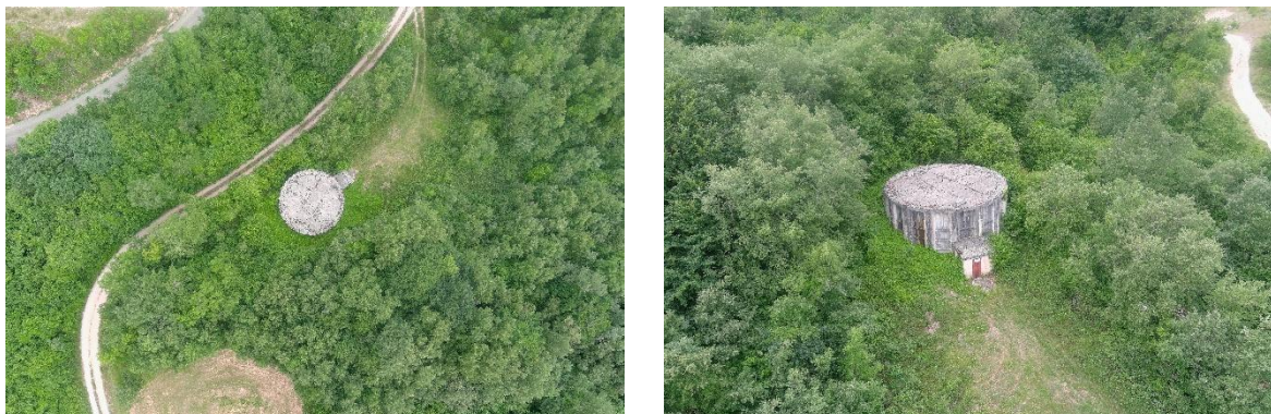
Estado actual de la zona del viejo depósito a derruir.
