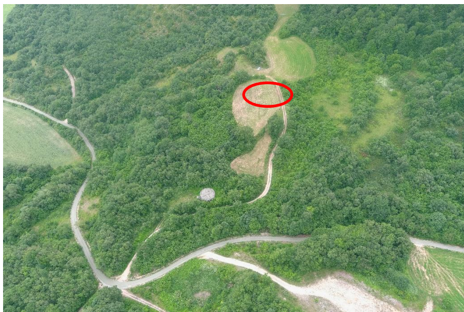
Futura localización del nuevo depósito de Lagrán junto al camino (rojo) y no muy alejado del depósito actual.
